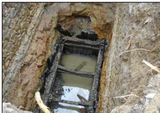
Vues de l'effondrement de l'orifice du puits LAURIERE (27 novembre 2015)
