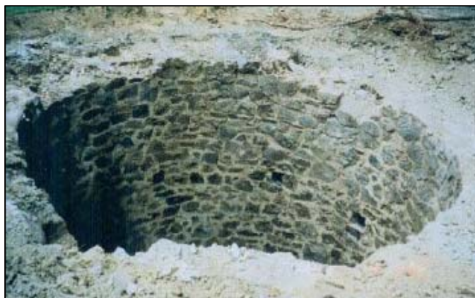
Vues de la maçonnerie du puits DUPONT avant remblayage et dallage (Mme PERICAUD, 1999)
