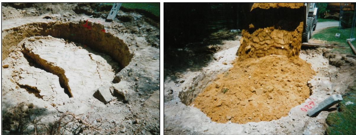
Remblayage du puits DUPONT, tassement des remblais (Mme PERICAUD, 1999)
