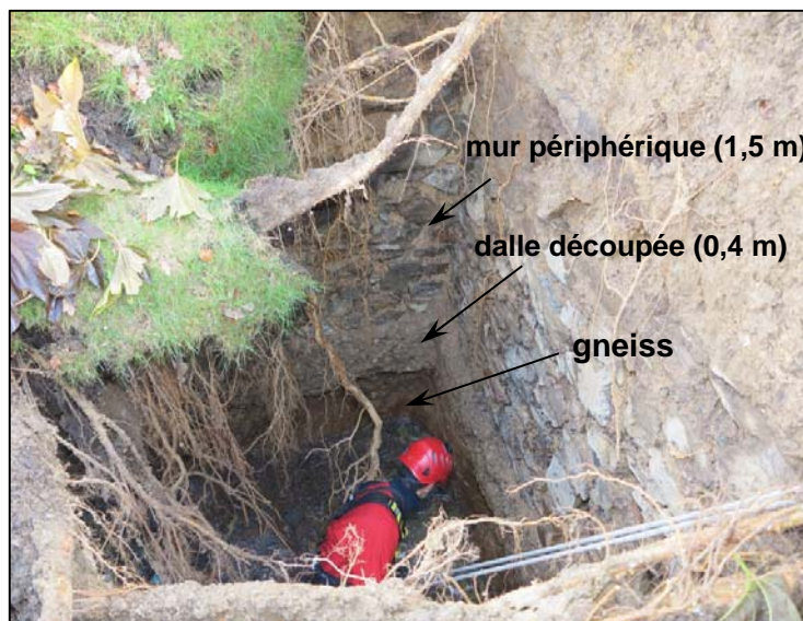
Vues de l'effondrement de l'orifice du puits LAURIERE (27 novembre 2015)
