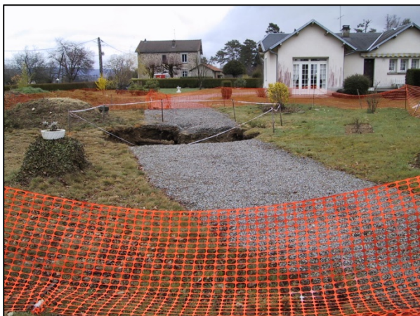
Fontis en bordure SW de la dalle du puits DUPONT (BRGM, juillet 2002)
