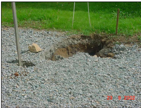
Remobilisation des remblais en bordure de la dalle du puits DUPONT (BRGM, septembre 2002)
