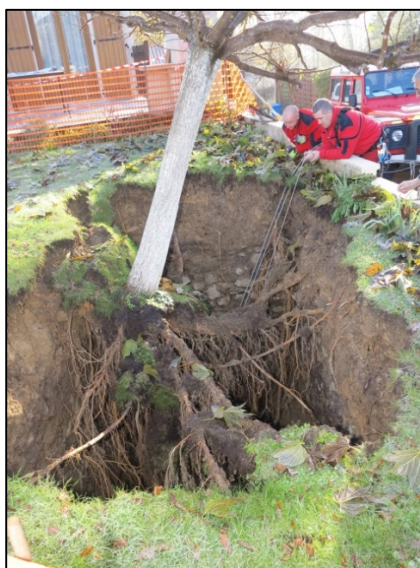
Vues de l'effondrement de l'orifice du puits LAURIERE (27 novembre 2015)
