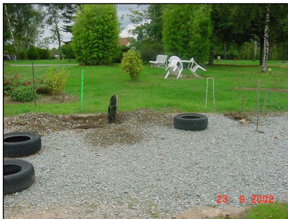
Remobilisation des remblais en bordure de la dalle du puits DUPONT (BRGM, septembre 2002)
