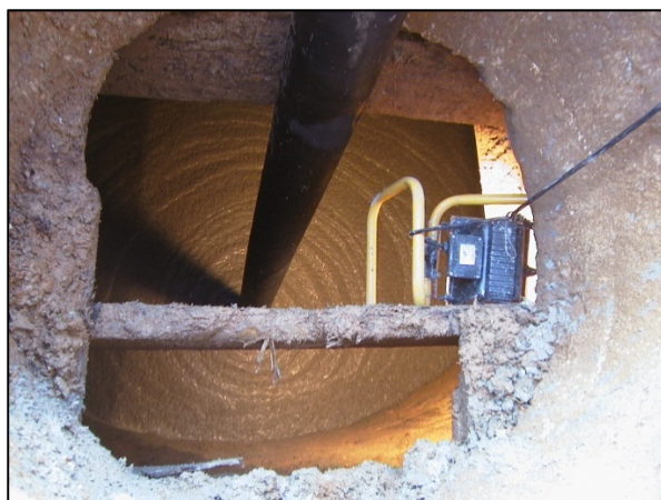
Coulage du bouchon autoportant du puits DUPONT, regard de visite (SAM, août 2005)
