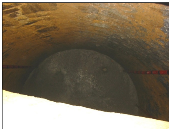
Coulage du bouchon autoportant du puits DUPONT, regard de visite (SAM, août 2005)
