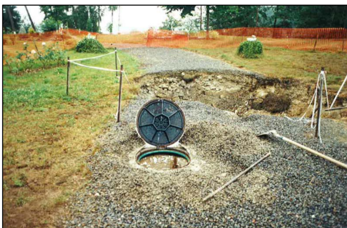
Fontis en bordure SW de la dalle du puits DUPONT, puits regard de visite (MICA, juillet 2002)
