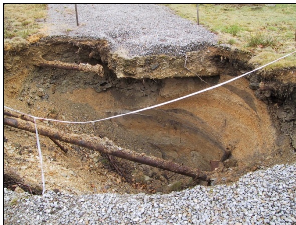
Fontis en bordure SW de la dalle du puits DUPONT (BRGM, juillet 2002)
