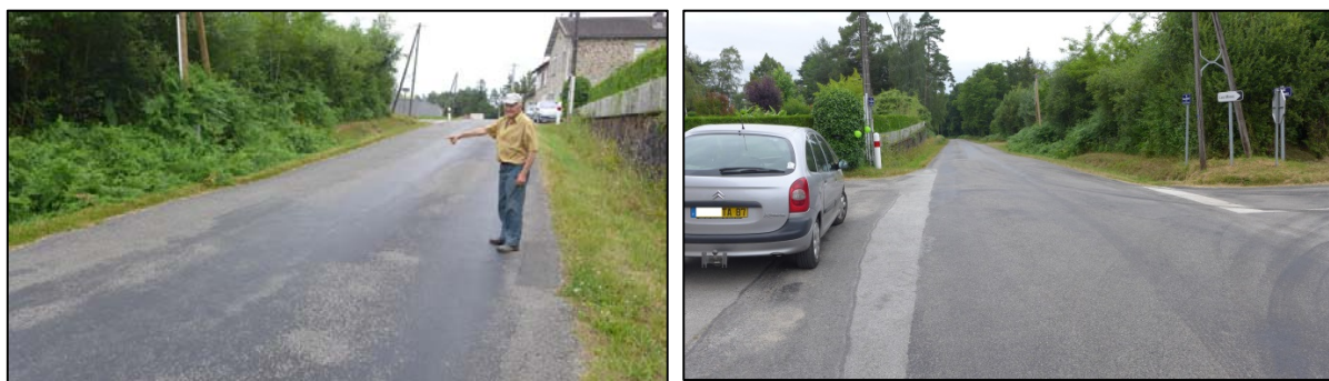
Vue 2016 de la chaussée RD 39. Zone d'affaissement au droit du filon COURIAUX traitée par injection de coulis
